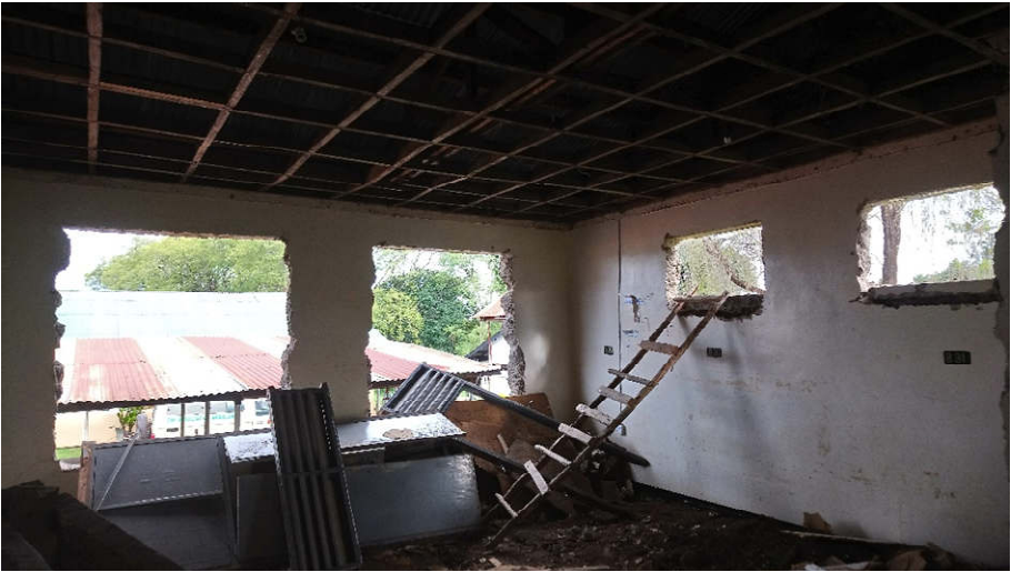
Baubeginn für die Renovation der Intensivstation.
