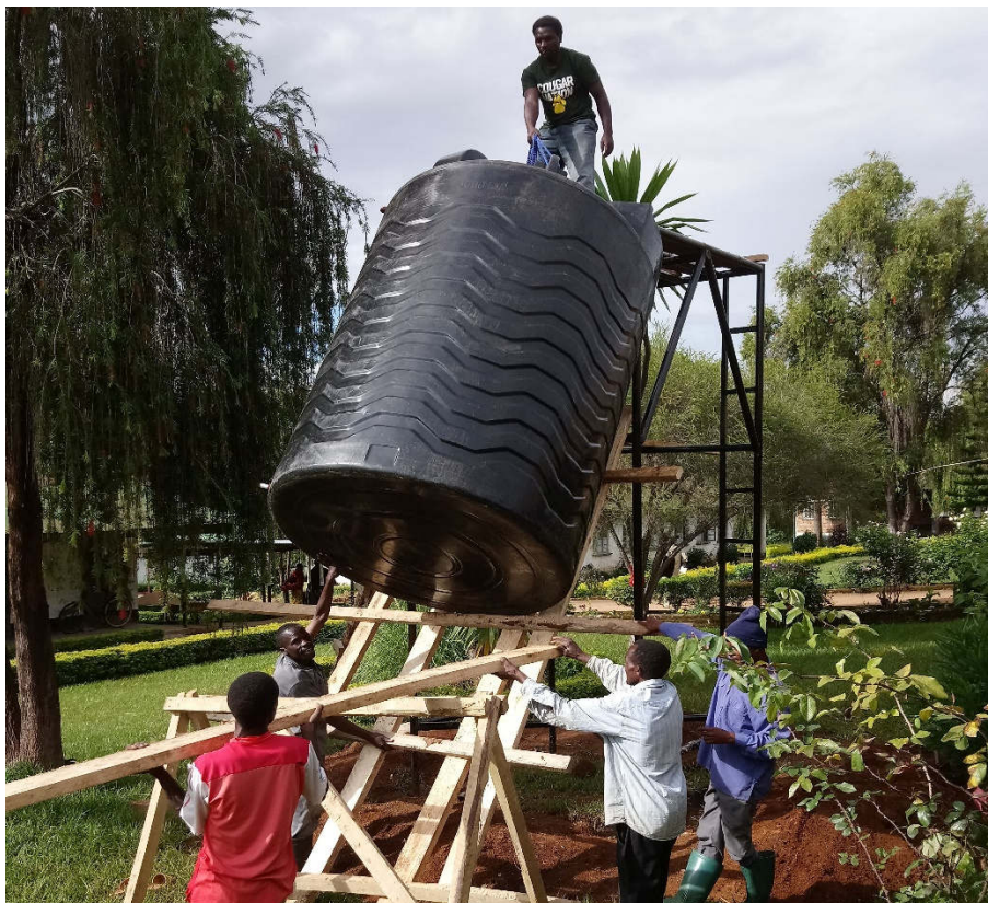
Renovation der Intensivstation im Mbozi Mission Hospital: Ein neuer Wassertank wird installiert.
