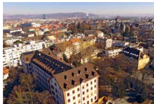
Das Gebäude der Basler Mission mit Hotel Odelya und Blick auf die Dächer von Basel.
