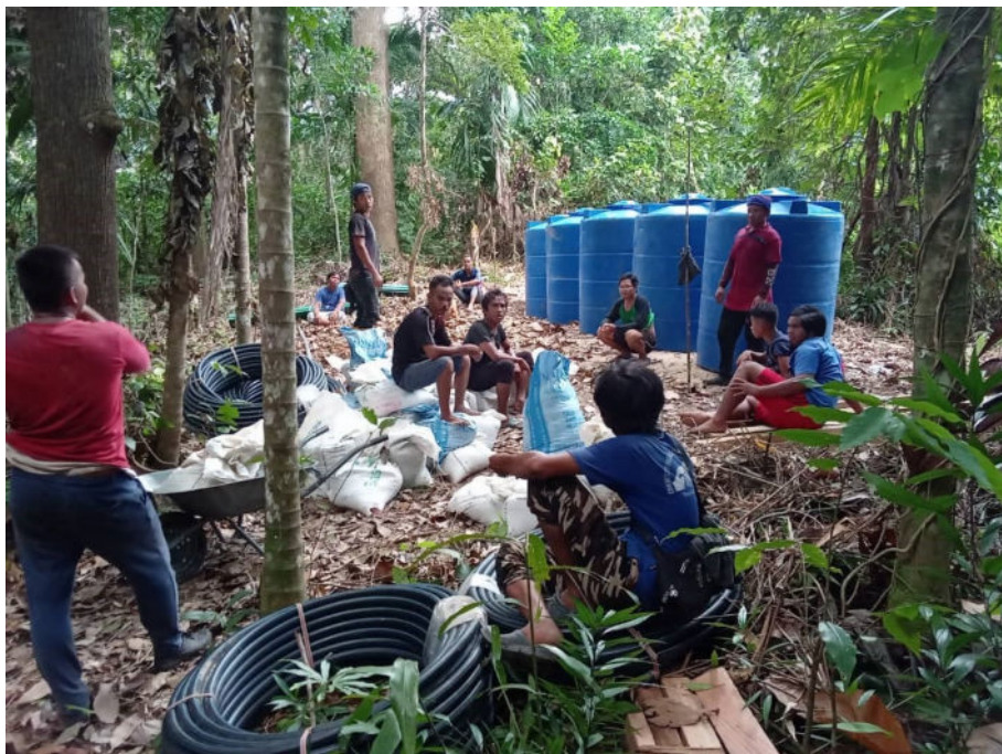
Arbeit am Wasserprojekt im Dorf Palak auf der Insel Banggi. Foto: PCS
