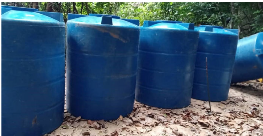
Blaue Tanks dienen im Projekt als Wasserspeicher. Foto: zVg
