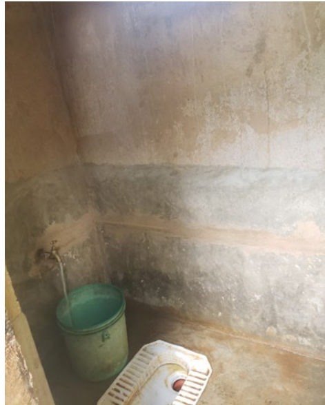
Die renovierte Toilette
