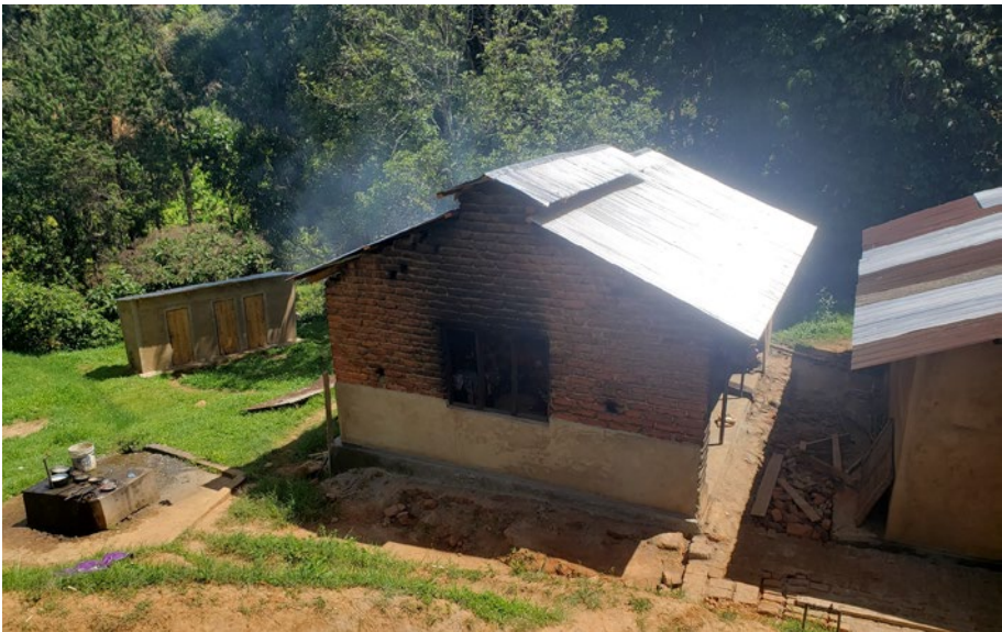
Die Angehörigenunterkunft nachher mit dem sanierten Küchendach und renovierten Toiletten sowie Duschen (links).
